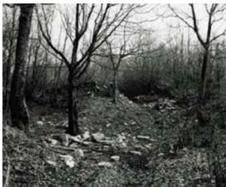
Slika 3. Pogled s humka na mjestu južne kule prema ulazu u stambeni dio prije početka radova 1979. godine
